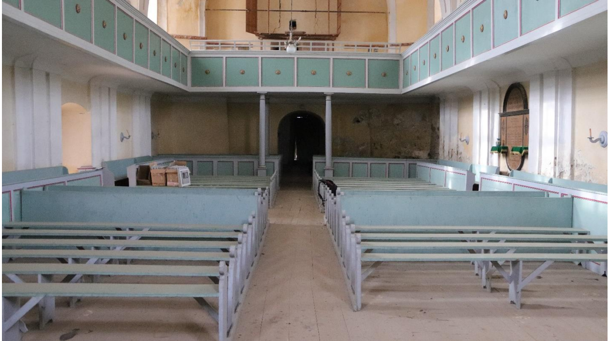
Fig.23. Spațiu interior- vedere spre vest
