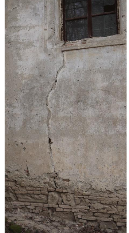
Fig.13. Fisuri verticale în zona inferioară a ferestrelor de pe elevația nordică a navei
