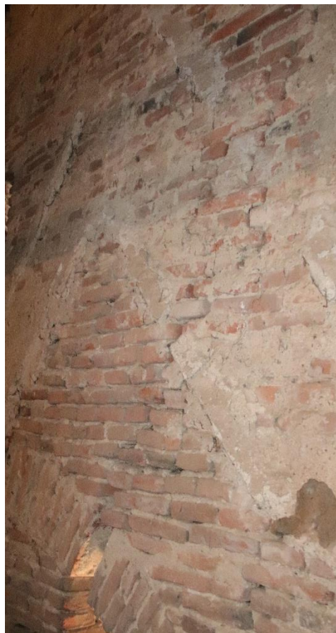
Fig.41. Urme ale unei etape anterioare de construcție
