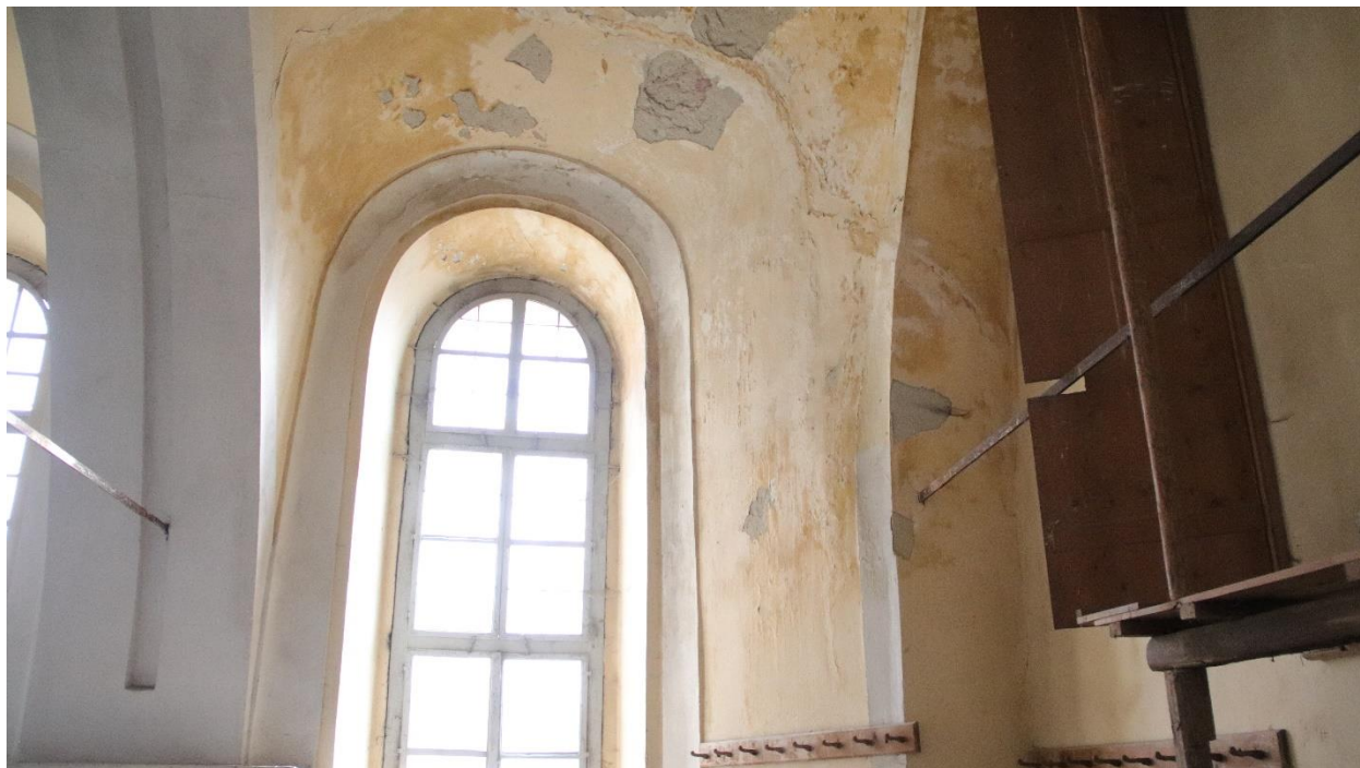
Fig.27.Ultima fereastră dinspre altar, unde punctele de prelingere ale apei au dus la pătarea zugrăvelii și la exfolierea acesteia
