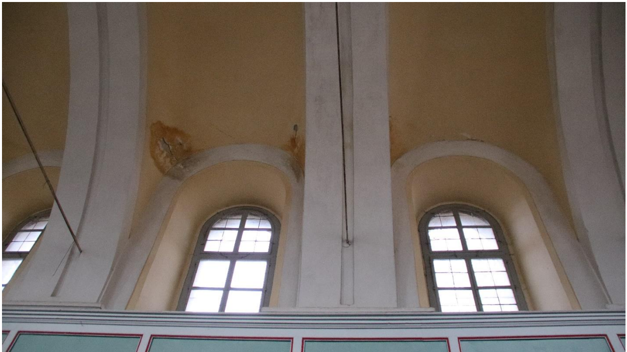
Fig.26. ultimele ferestre din extremitatea vestică a acestei fațade sudice prezintă puncte de umezeală datorate prelingerii apei prin învelitoare
