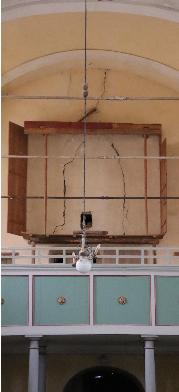
Fig.37. Fisură în zona fostei orgi
