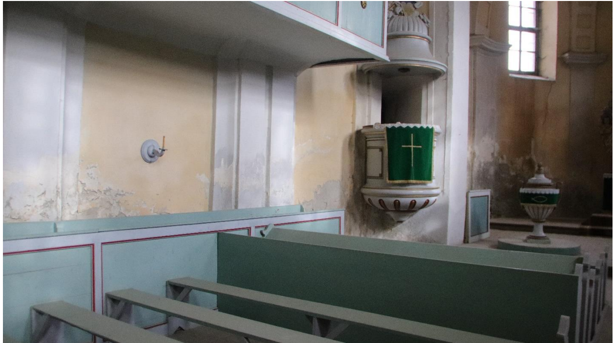
Fig.29. Umezeală pe peretele nordic
