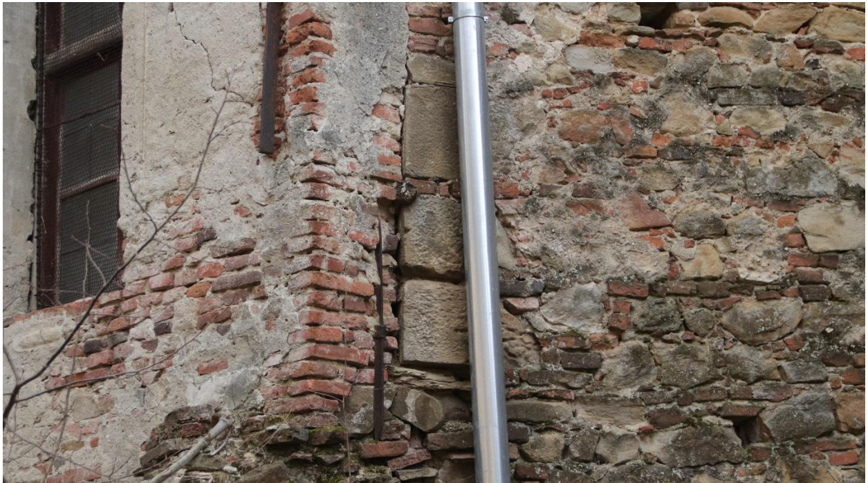
Fig.21. Nețesere a zidăriei elevației nordice.
