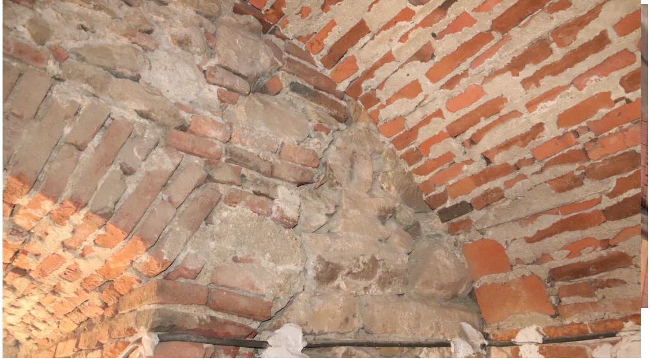
Fig.44. Neșesere a zidăriei dintre turn și navă
