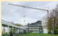
Das Titelbild zeigt eine Etappe der Sanierung unserer Kirche.
