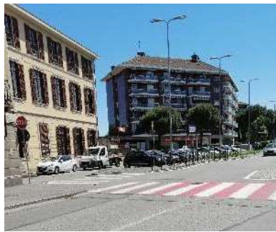
Attraversamento rialzato in corrispondenza dell'intersezione con via G. Amati
