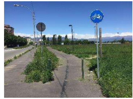
Pista ciclabile lato Nord in corrispondenza dell'intersezione semaforizzata
