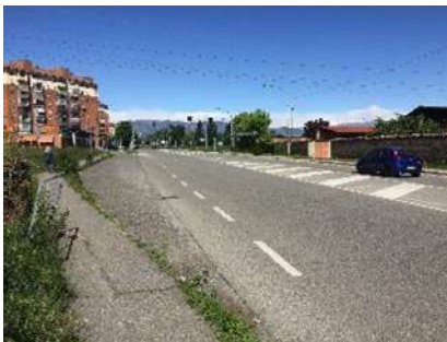
Corsia di ingresso in corrispondenza dell'intersezione
