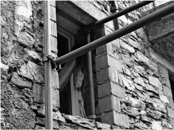
13 Eine Fenstererweiterung wird vorgenommen, Lionza.
