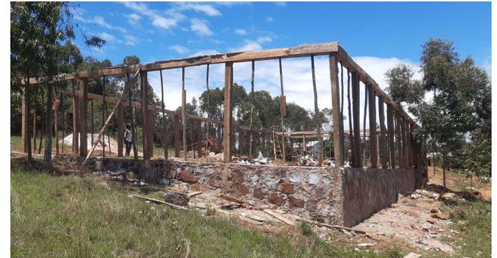
Baugründung (Streifenfundament), Stützkonstruktion
