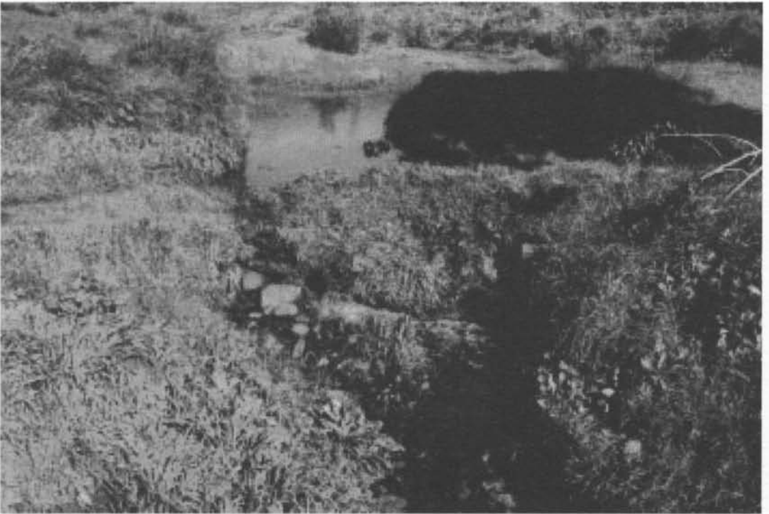
Foto 5.- El acueducto en el fondo del arroyo Vallehermoso y represamiento actual de sus aguas.
