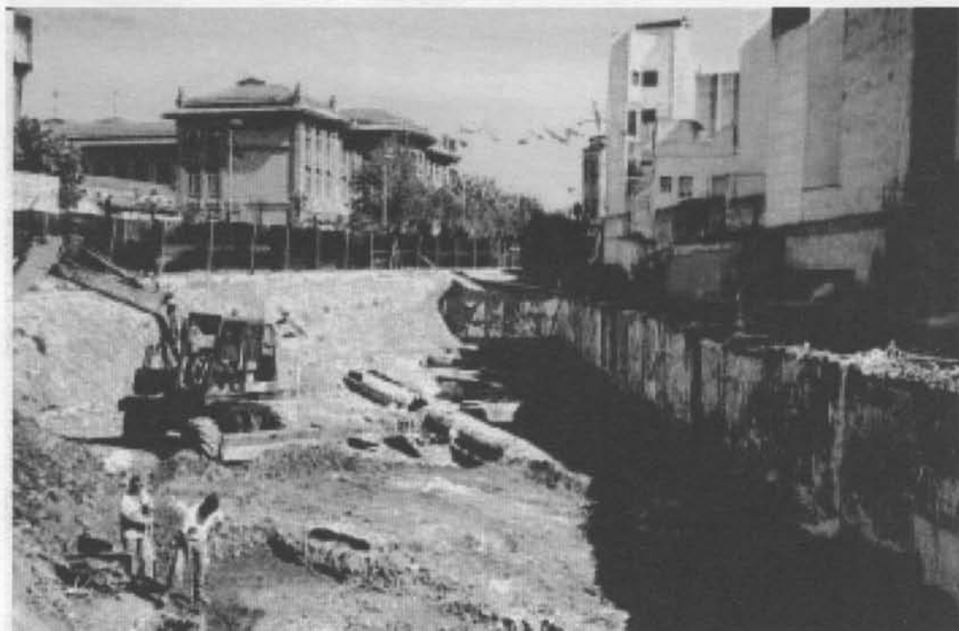
Acueducto detrás de la antigua Facultad de Veterinaria, que podría ser el citado qanat que se dirigía hacia el foso de la muralla de la Almedina-después de atravesar el Cementerio de 'Amir.
