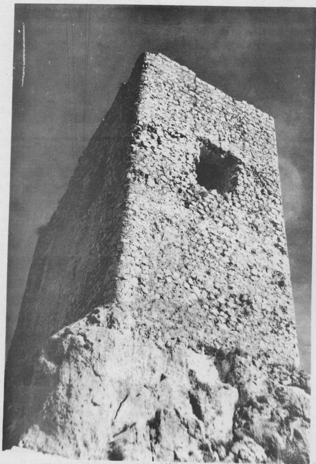
Castillo de Luque, detalle de la torre Norte en el que se aprecia el redondo de la fábrica en las aristas (Foto R. Gracia).
