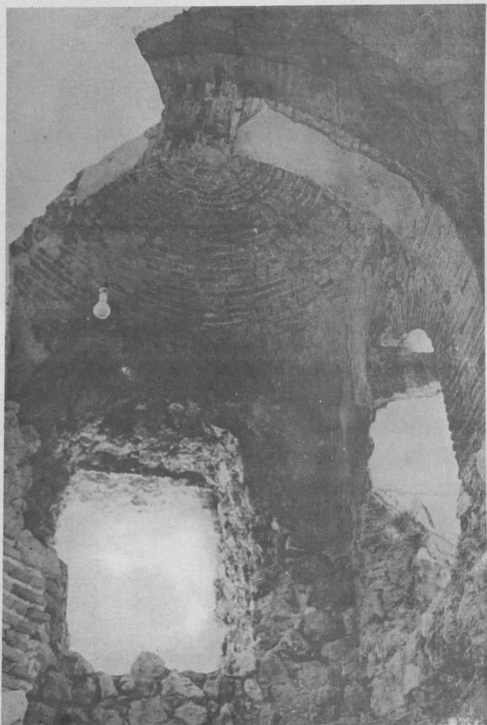
Castillo de Luque, bóveda y arco toral de las habitaciones altas de la torre Norte (Foto R. Cortés).
