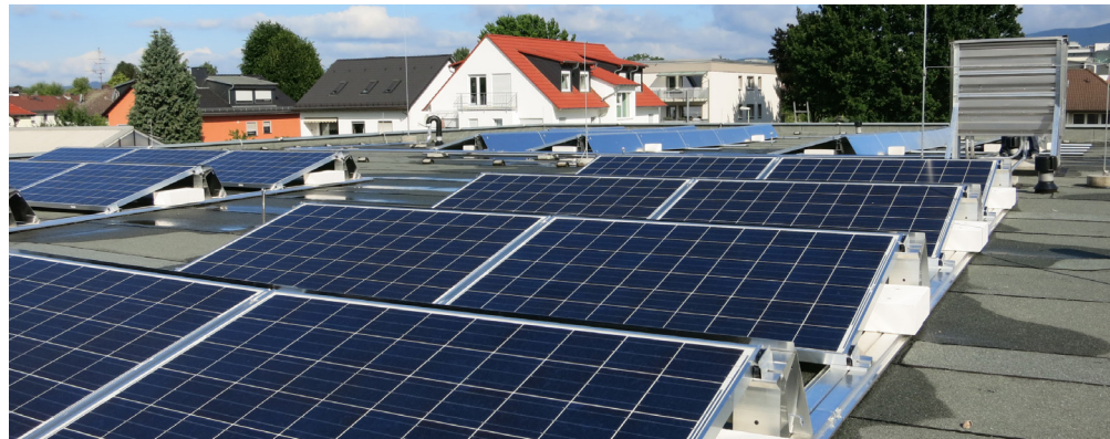
Solche Anlagen könnten in Eschborn künftig häufiger zu sehen sein. Foto: Stadt Eschborn
