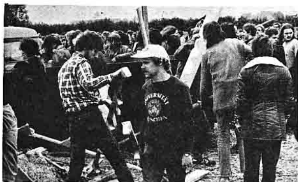
Geschmuggeltes Baumaterial wird abgeladen.
