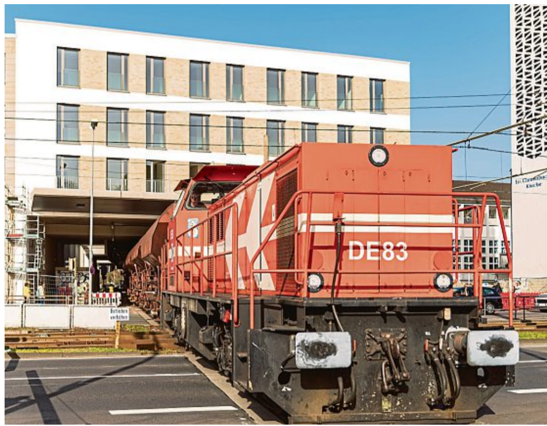
Durch den Gebäudesockel eines Wohnhauses in Braunsfeld fahren Güterzüge, die von der städtischen Häfen- und Güterverkehr Köln AG betrieben werden. Foto: Alexander Roll
