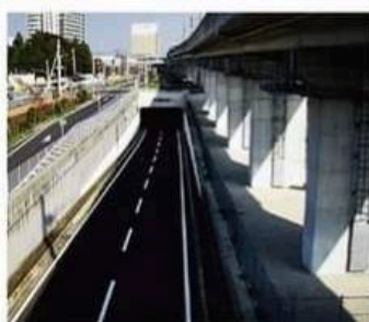
守谷トンネル
