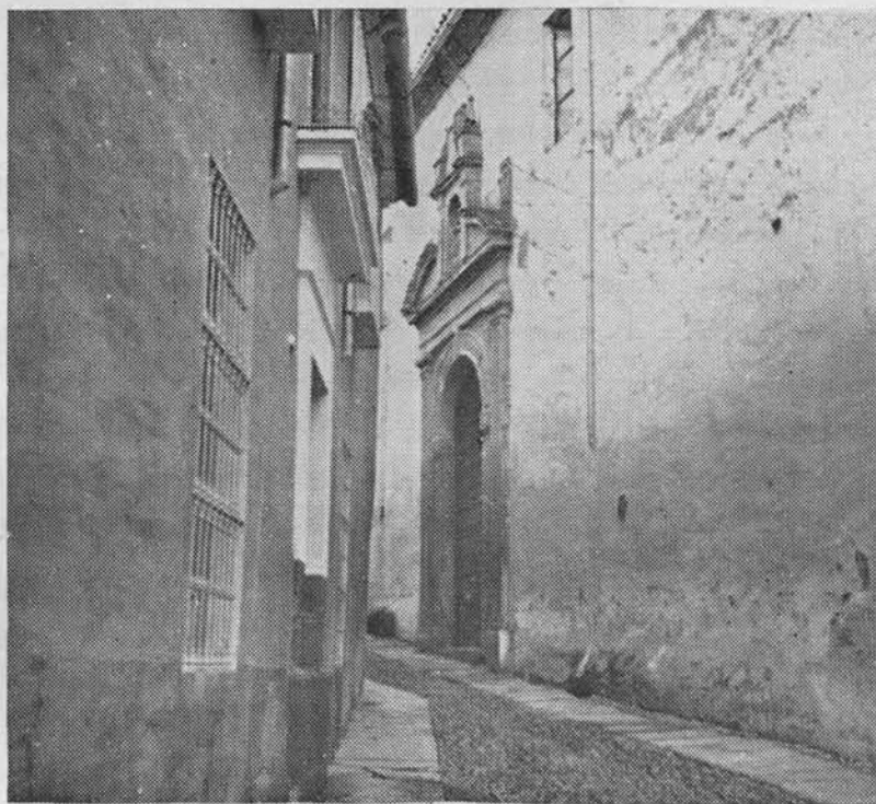
(Fig. 16.) Puerta principal de la iglesia del Hospital de Jesús Crucificado. La estrechez de la calle obligó a tomar la fotografía muy de costado.
