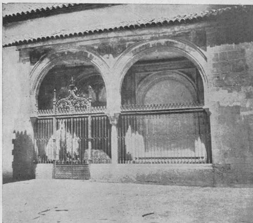
(Fig. 15.) Hospital de la Caridad. La fotografía reproduce las arcadas recientemente descubiertas que formaban el primitivo vestíbulo del Hospital.
