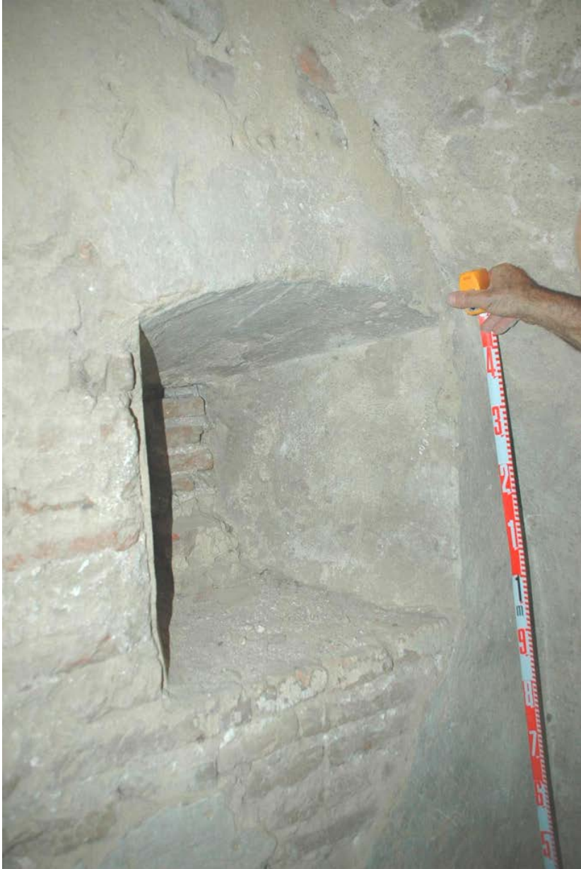
5. Tronera bajomedieval en el interior de la torre de Nuestra Señora del Castillo y que en su día formó parte de la casa-fuerte del comendador.
