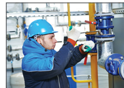
UMBAUARBEITEN / RECONSTRUCTION WORK
