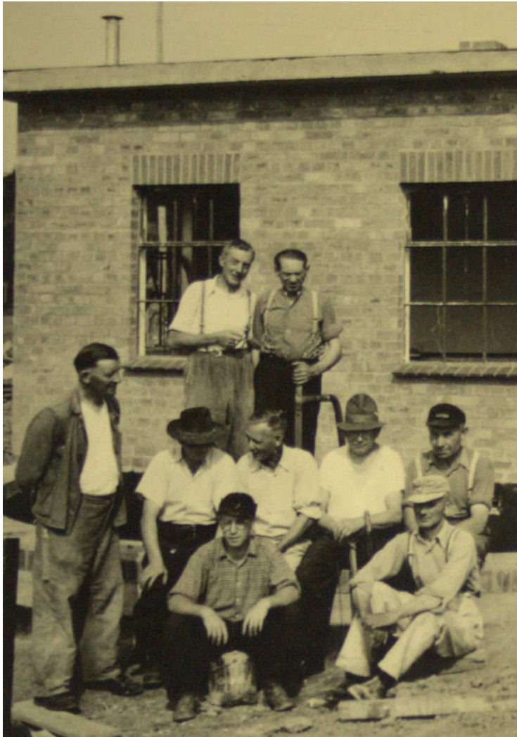
Der Wellbrunnen ist neu ausgemauert worden und ein neues Pumpenhaus wurde gebaut.
