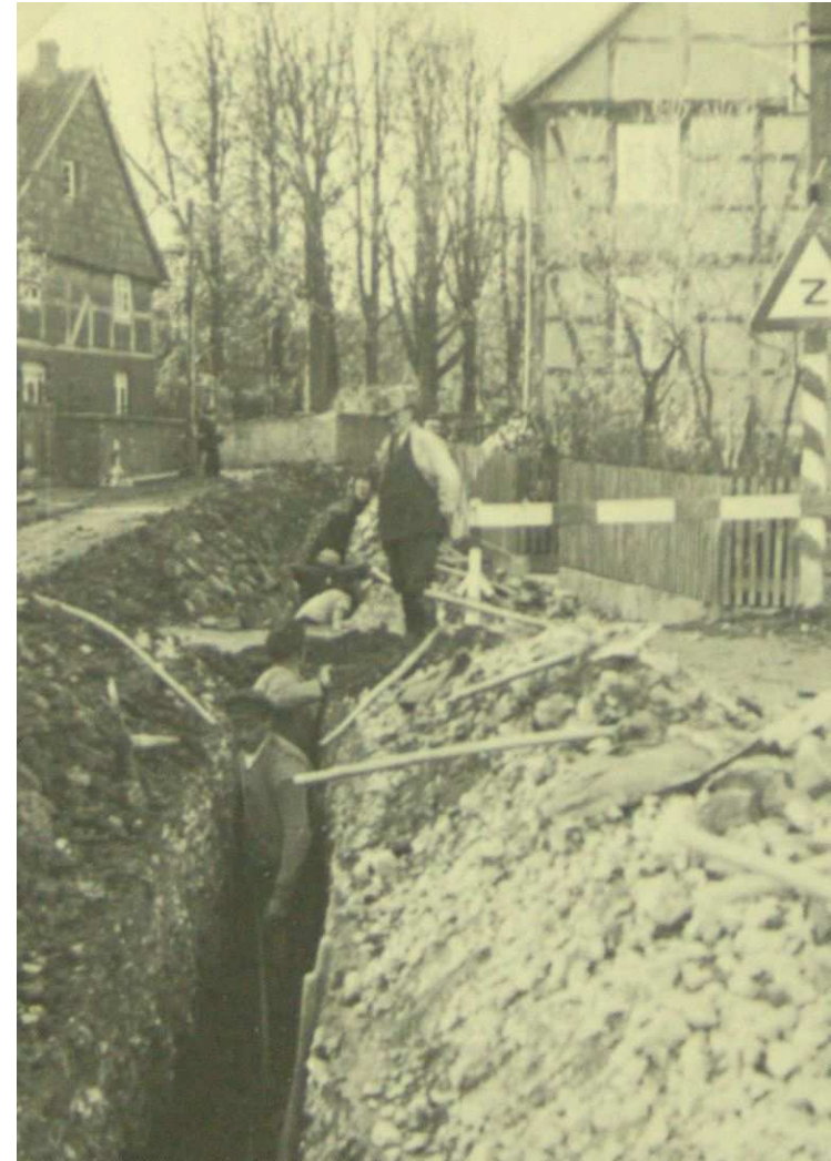
Im Ort werden Rohre verlegt zu den einzelnen Grundstücken.
