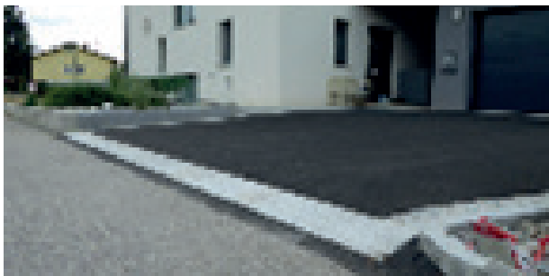
Abb. Garagenzufahrt mit Schutzschwelle
