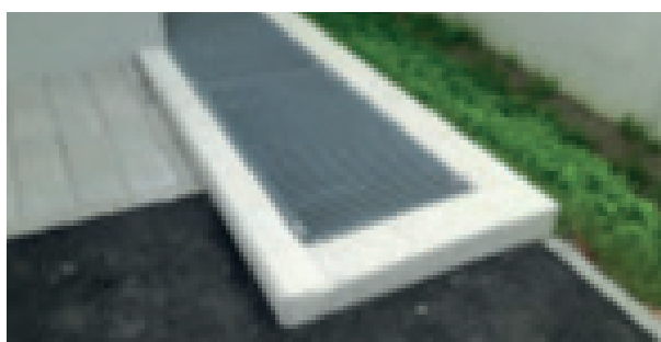
Abb. Kellerfenster mit erhöhtem Lichtschacht
