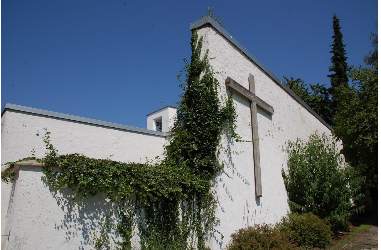
Abbildung 73: Horst Döhnert, Gnadenkirche, 1955-1956, Gangkofen, Ostfassade
