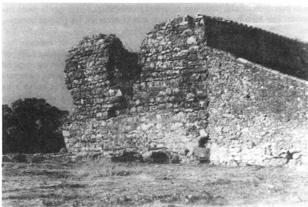
Figura 2. Fachada occidental de la Torre del Ochovo.
