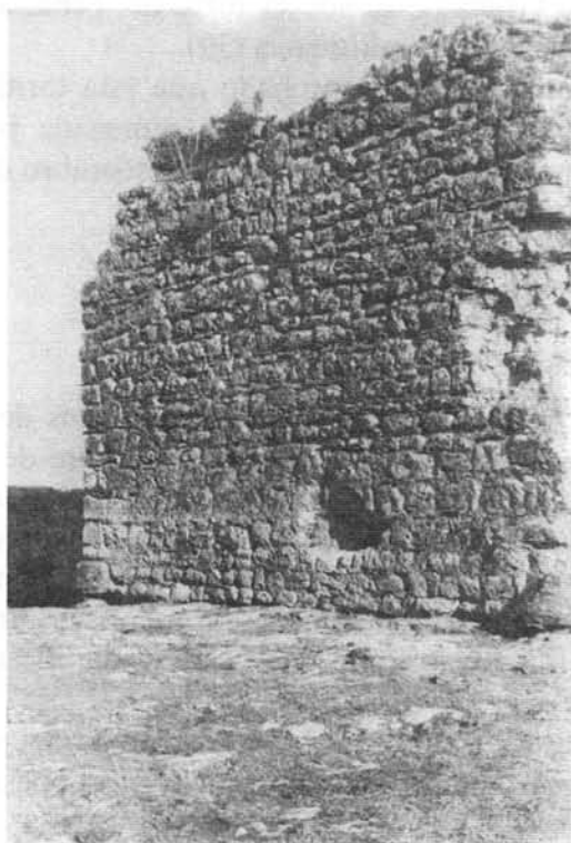
Figura 3. Fachada septentrional de la Torre del Ochavo.
